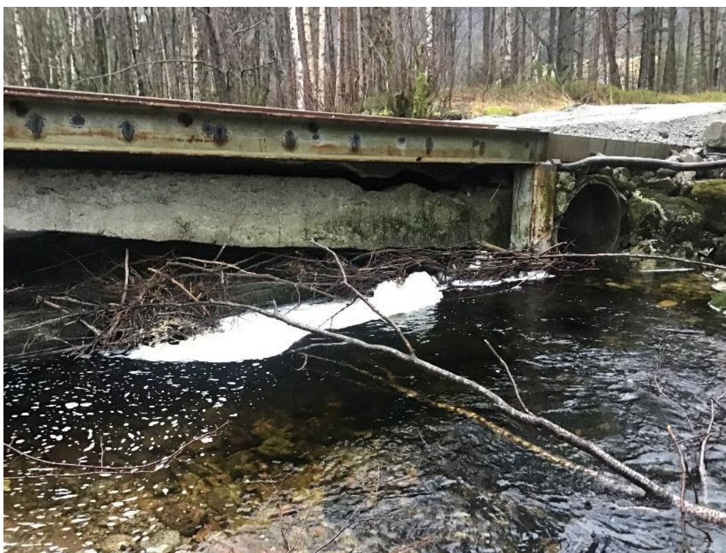
Figur 7. Bro/kulvert ved hovedinngangen til masseuttaket.
