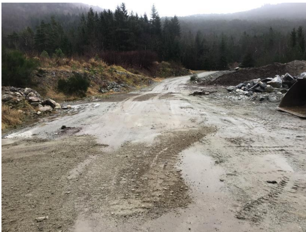
Figur 5. Fra nordlige del av dagens anlegg ved «inngangen». Bilde tatt mot sør.
