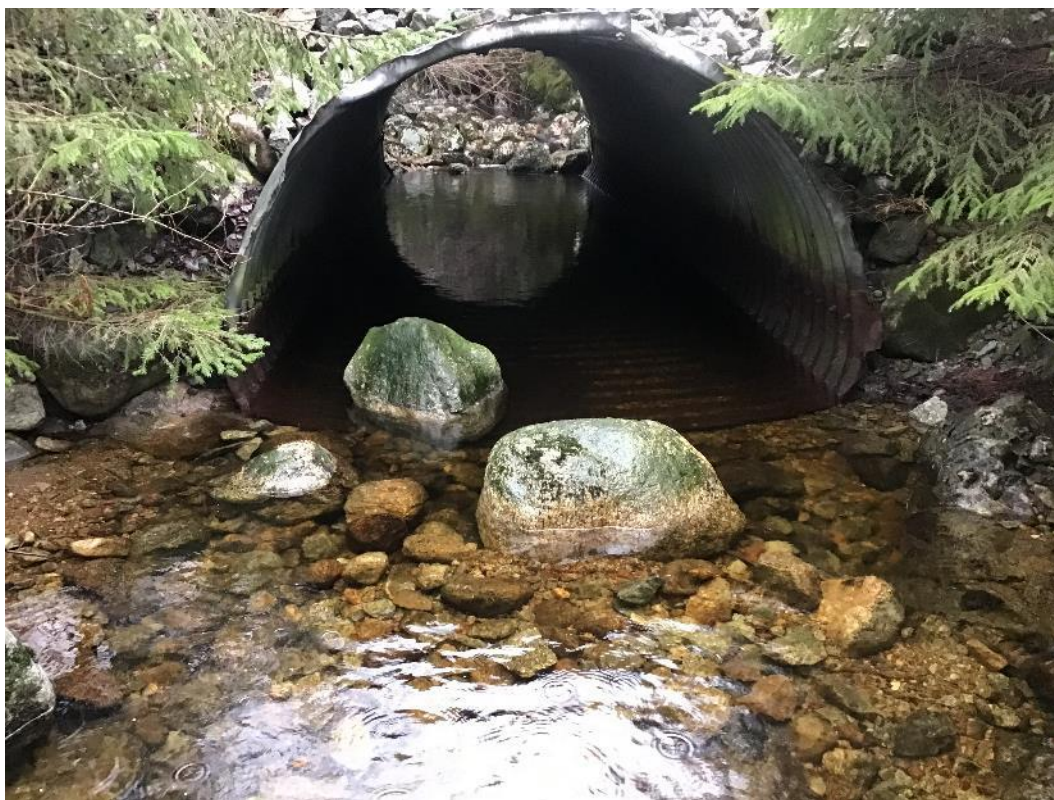
Figur 6. Nedstrøms kulvert for veg mellom nordre og søndre del av dagens anlegg.
